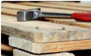
Einschlagen herausstehender Befestigungselemente.
