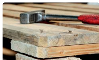
Einschlagen herausstehender Befestigungselemente.
