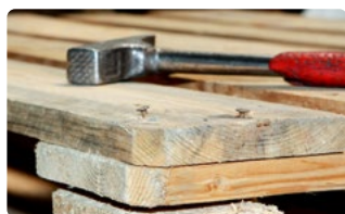
Einschlagen herausstehender Befestigungselemente.
